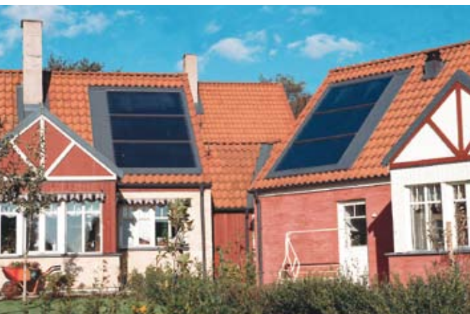
Maison individuelle en Suède : 18 m 2 de capteurs, 1 500 litres de stockage, appoint par chaudière à granulés bois.
