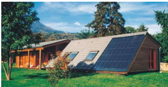
Maison individuelle à Chapareillan (Isère) : occupée par quatre personnes, 16 m 2 de capteurs en toiture.
